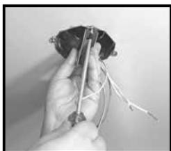
Instale o suporte de fixação ao teto. Não utilize a caixa plástica para fixação do suporte. Utilize caixa de metal e certifique-se de que a caixa de luz no teto pode suportar aproximadamente 28kg, caso contrário instale diretamente na laje utilizando buchas S-10 e parafusos com rosca soberba de 6,35 x 50,8mm bem apertado (quando for estuque, trave pela parte superior).
